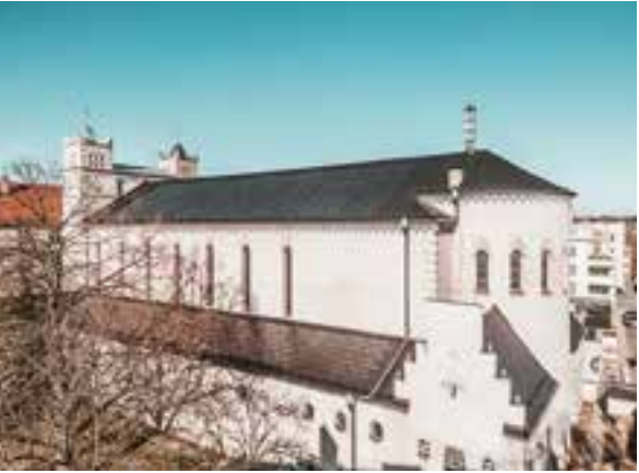
Épület: St. Karl templom Borromäus Ternék: PREFA napelemes tetőfedő panel 1.233 db., PREFA R.16 tetőfedő panel: kb. 500 m 2 , teljesítmény 123 kWp, beépített kábelek hossza 4.600 m Tetőfelület: kb. 800 m 2 Várt hozam: 93 MWh/év Építéset: Peter Troppmann Építésziroda Bádogosmunka: Erhard Achtelstetter GmbH PREFA projektfelelős: Holger Voit Beruházó: St. Karl Egyházközség Borromäus
